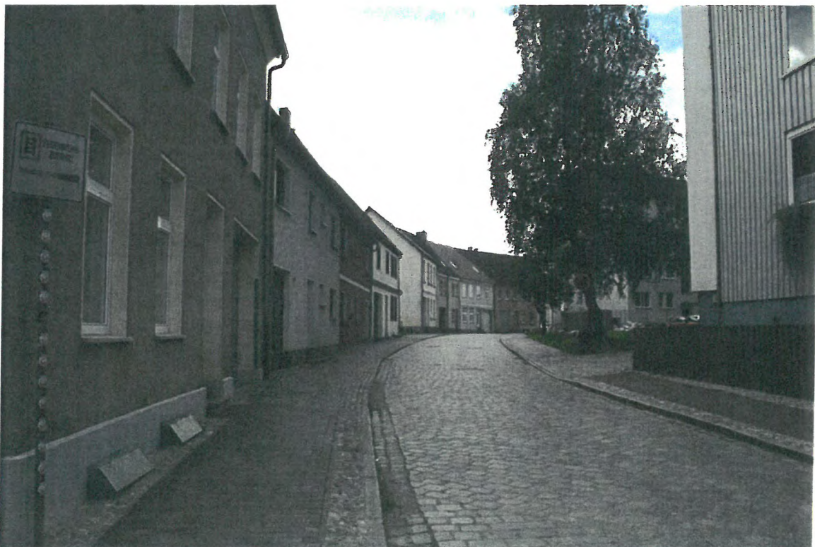
Abbildung 4: Neugestaltung Lange Straße / Pastinakelstraße nach Maßnahmenabschluss im September 2017
