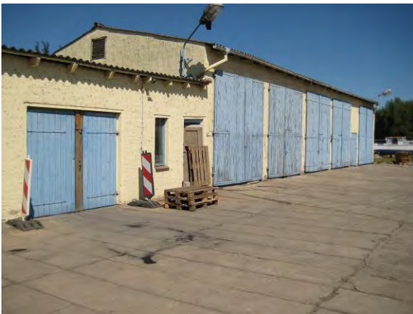
Abb. 16: Mischgebiet MI 1 mit westlich gelegenen Gebäude (11.06.2015)
