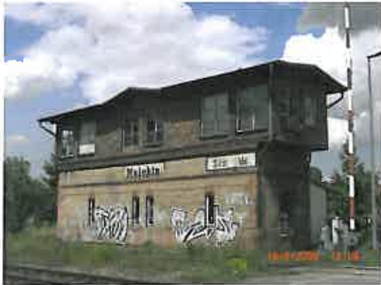
Stellwerk 1 (Einfahrt vor Koesters Eck)
