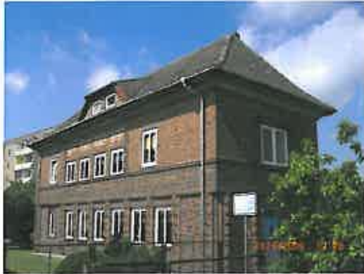
Basedower Str.65 Umspannwerk
