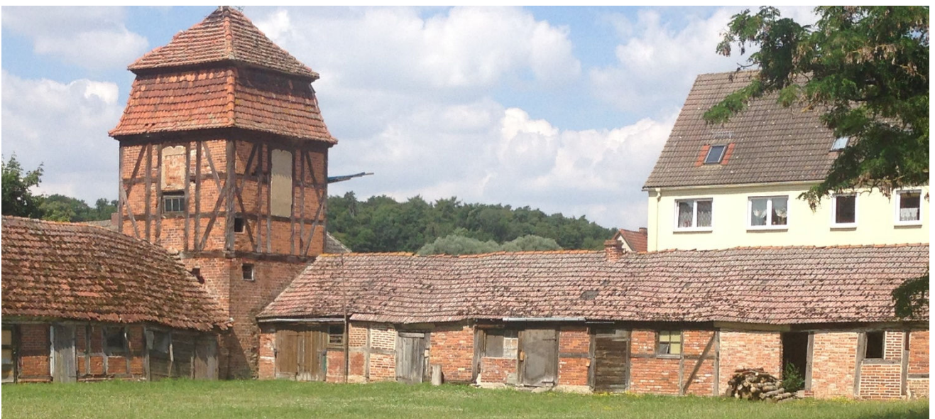
Schlosstraße ehemalige Stallungen und Taubenturm: im Bestand gefährdet, Denkmal, komplett leer stehend
