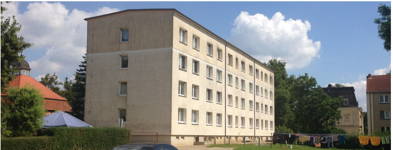
Schlossstraße 12-14: schlechter Bauzustand, 4 % Leerstand
