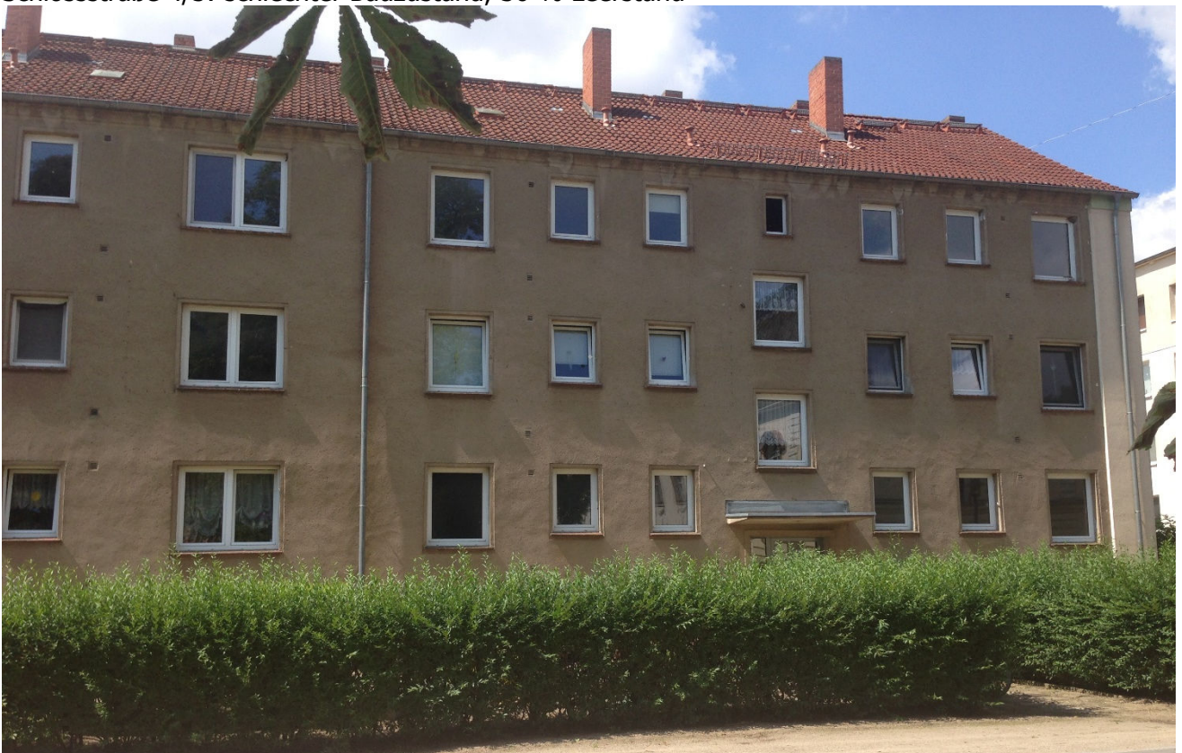
Schlossstraße 2/3: schlechter Bauzustand, 53 % Leerstand
