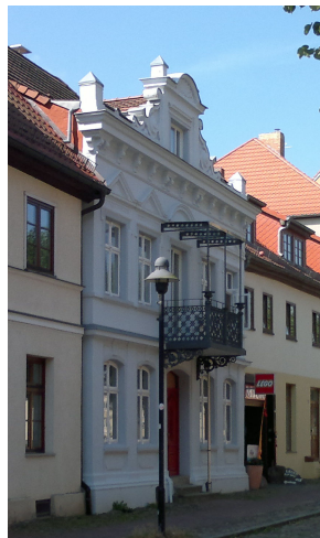
Schweriner Str. 17 (Sanierung 2012/13)
