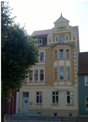
Schweriner Str. 11 (Sanierung 2011)
