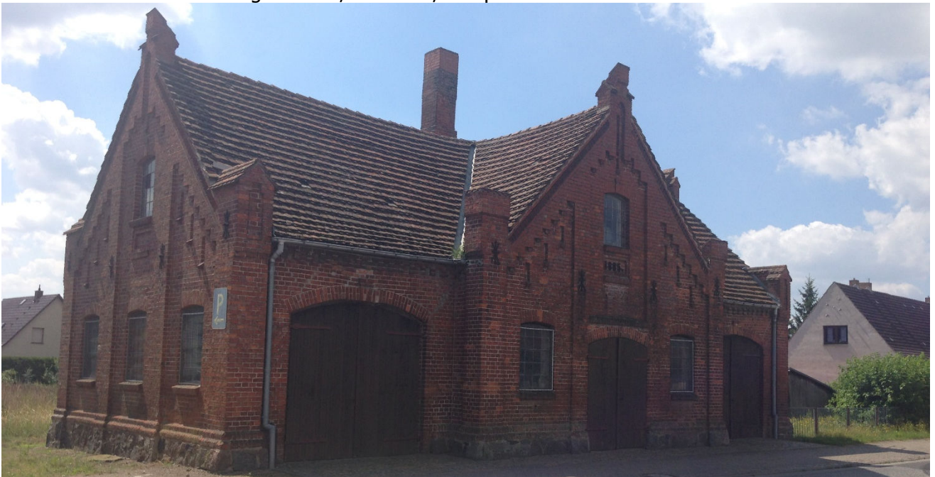
Dorfstraße ehemalige Schmiede: schlechter Bauzustand, Denkmal
