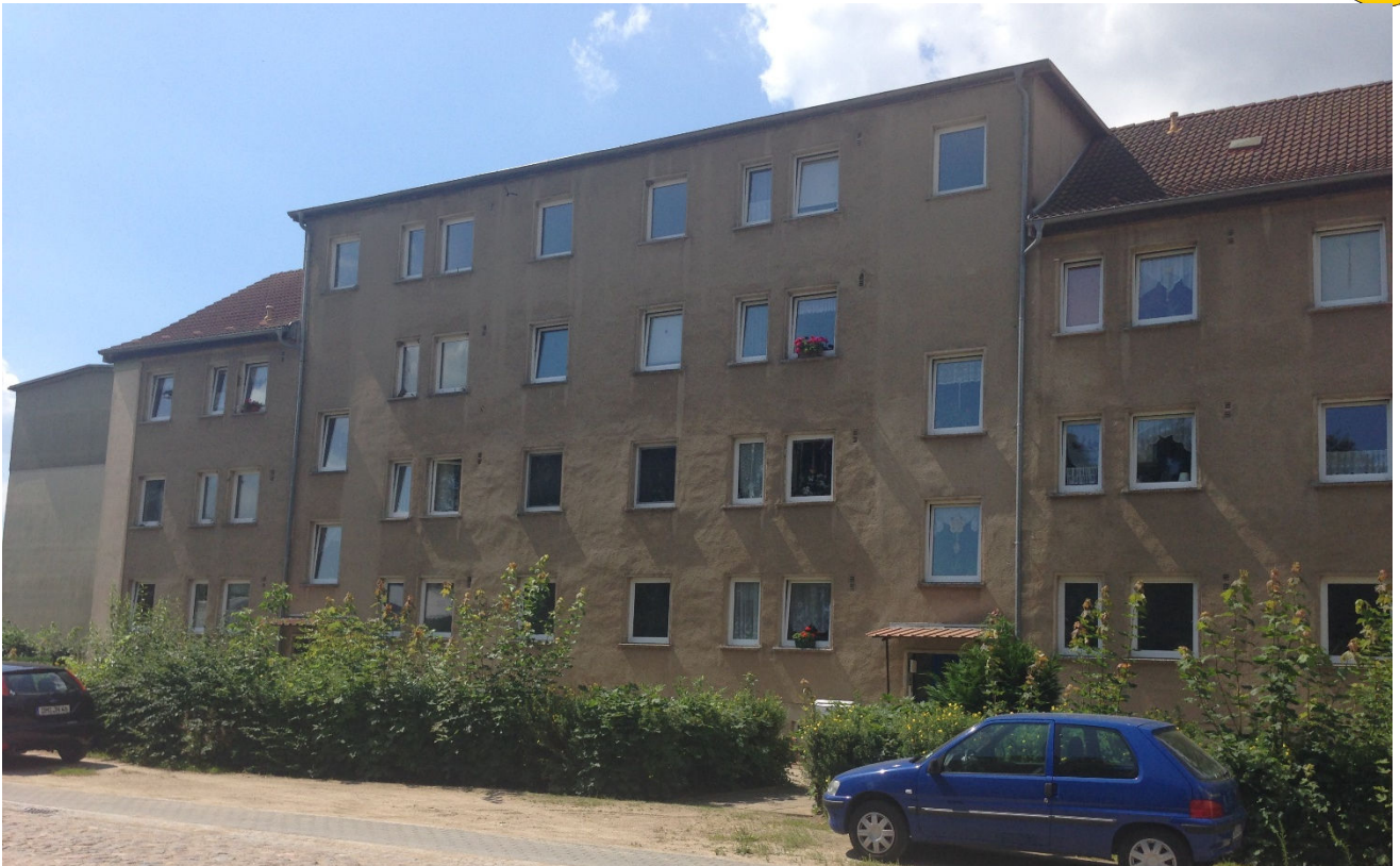
Schlossstraße 4/5: schlechter Bauzustand, 36 % Leerstand
