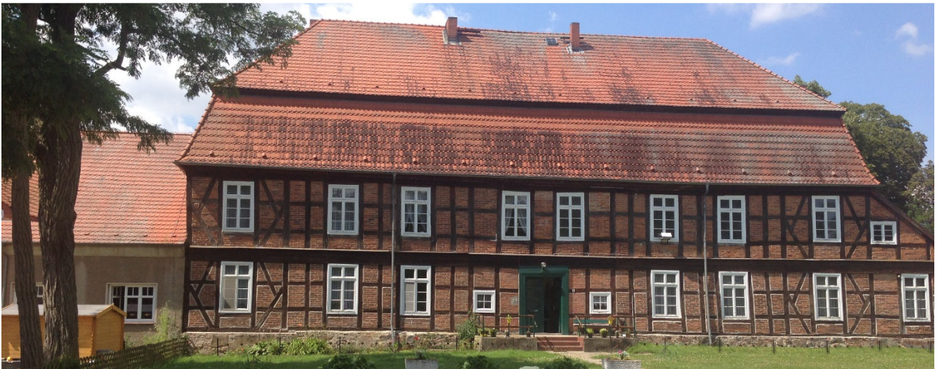
Schlosstraße 11: mittlerer Bauzustand, Denkmal, Wohnnutzung
