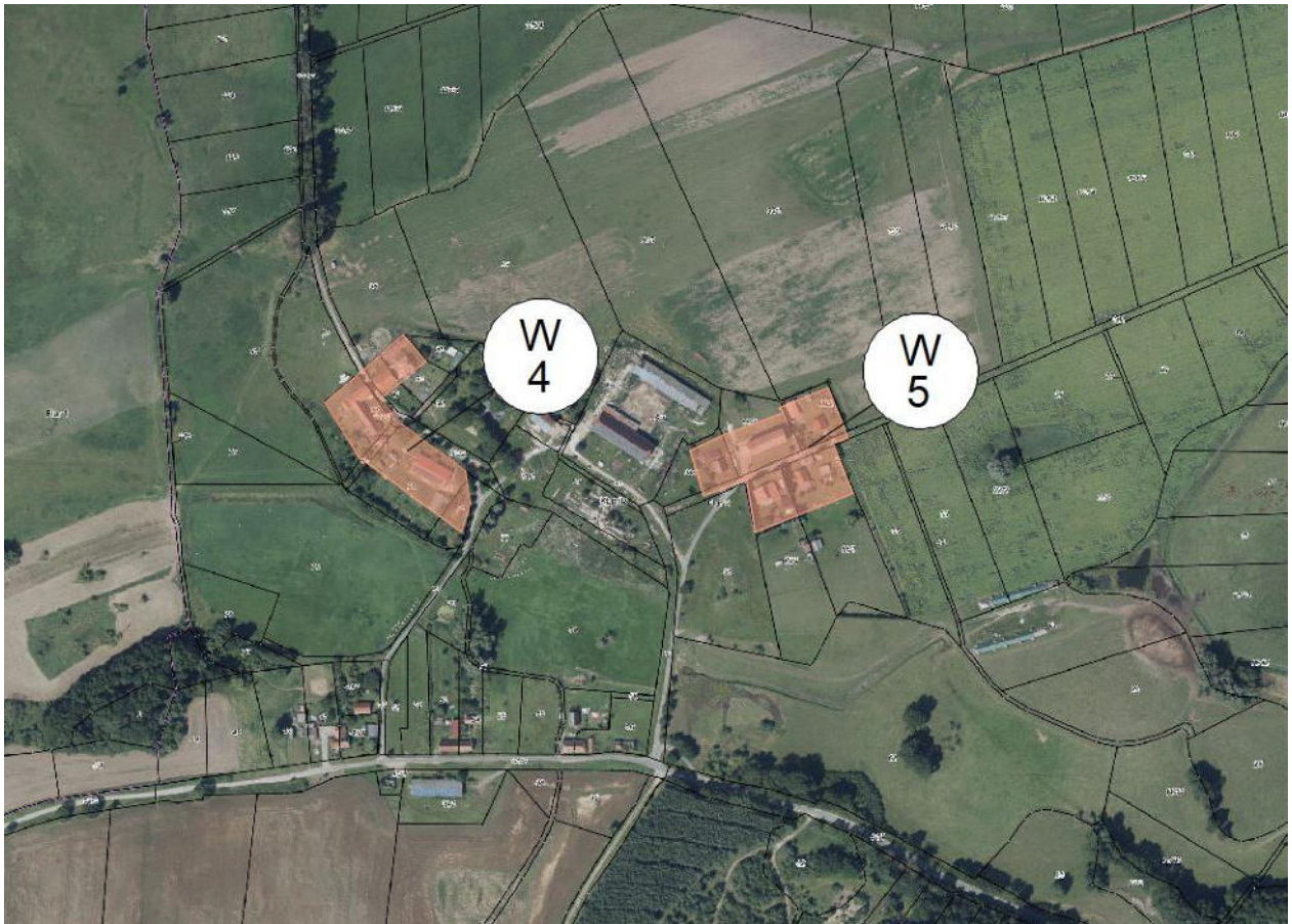
Abb. 13: Luftbild der Wohnflächen W4+5 (Quelle: GeoPortal.MV vom 03.01.2022) bearbeitet ign Melzer & Voigtländer Ingenieure PartG-mbB
