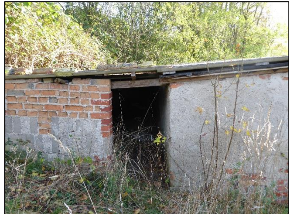
Abb. 6: Nördlicher Anbau am westlichen Gebäude. Eingang für Prädatoren.
