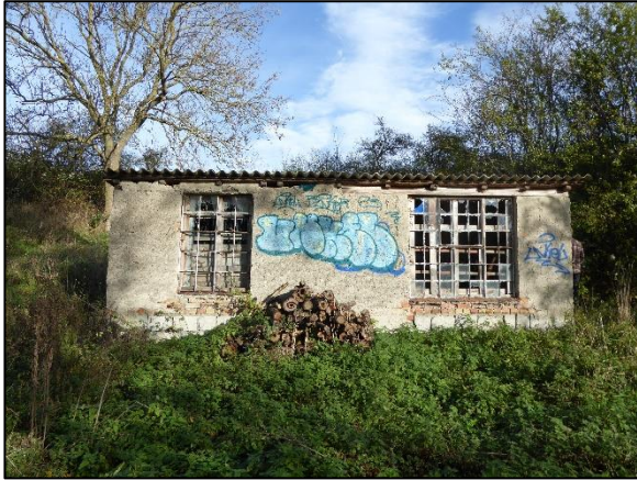
Abb. 3: Fensterfront des westlichen Gebäudes.
