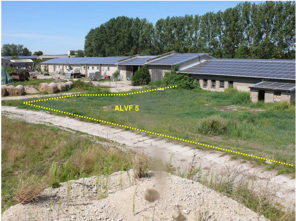
Foto 7: Nördliches Stallgebäude (Gebäudekomplex B) vom Recycling-Haufen mit Blick Richtung Nordwesten
