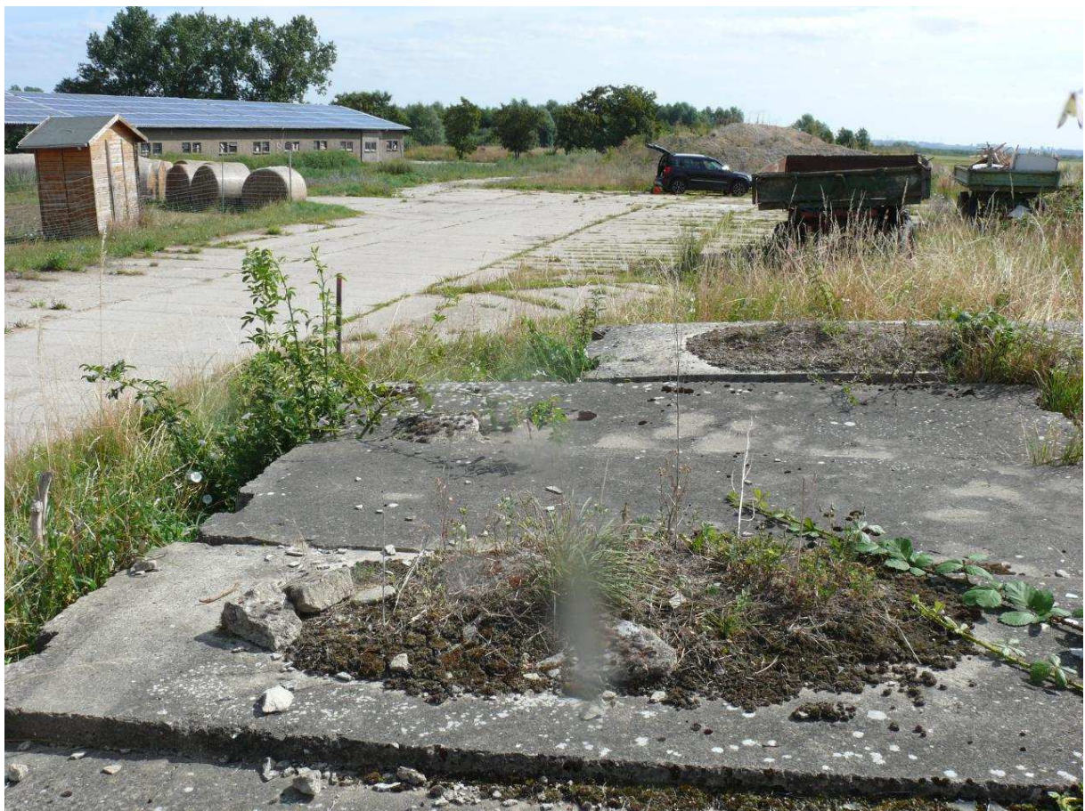
Foto 10: Klärgrube I (ALVF 6) mit BS 11/22 im Hintergrund
