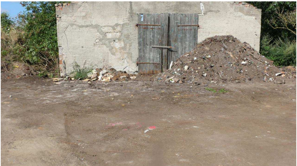
Foto 4: Dunglege 1 (ALVF 2) mit Bohrpunkt BS 2/22 vor (Gebäudekomplex A)
