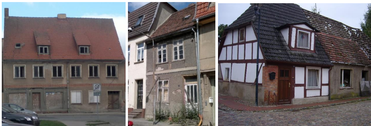
Abbruch 2017 - Achterstraße 9 und Pastinakelstraße 3 Abbruch 2013 - Wolfssteig 34/36
