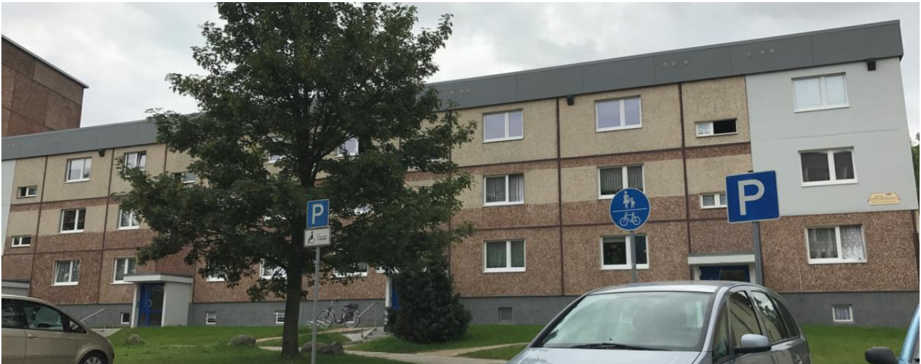
etagenweiser Rückbau Am Zachow 23-26 im Jahr 2016
