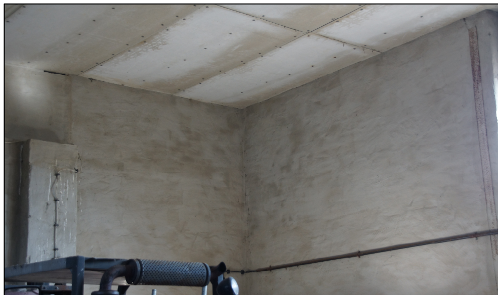
Abb. 6: Innenansicht der Halle 1 (Foto: GL 22.03.2022)
