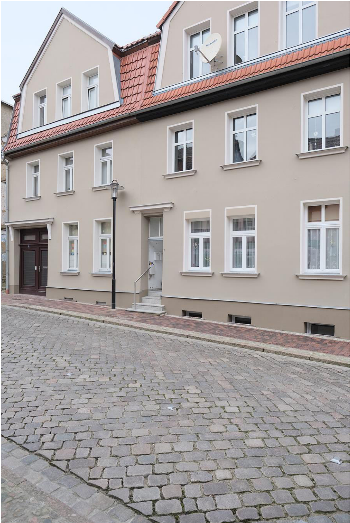
Abbildung 15: Pastinakerstraße 7 nach erfolgter Sanierung
