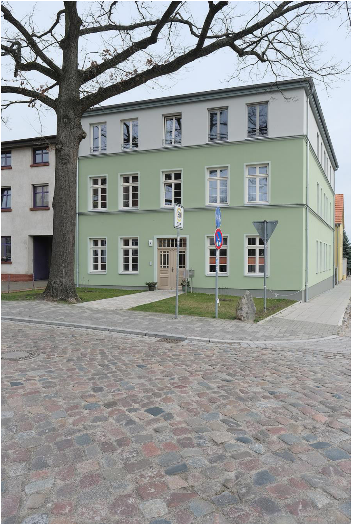
Abbildung 10: Sanierung/Neubau Lindenstraße 5 nach Fertigstellung
