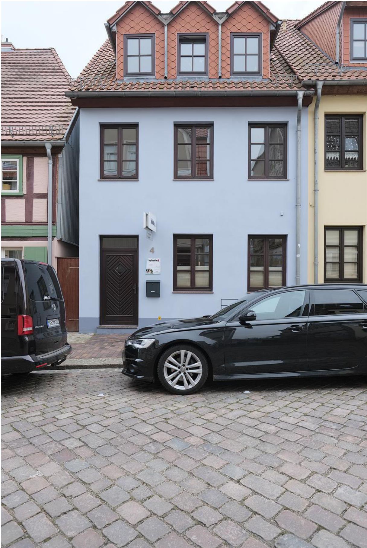
Abbildung 16: Pastinakelstraße 4 nach erfolgter Sanierung
