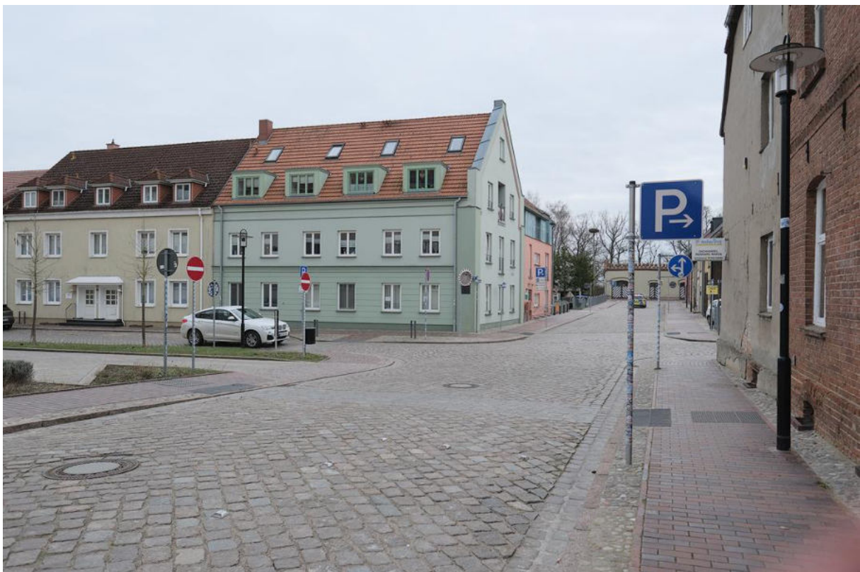
Abbildung 4: Blick entlang der sanierten Petersilienstraße
