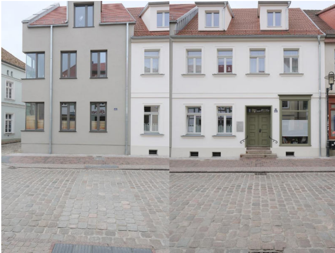
Abbildung 9: Steinstraße 20/22 nach erfolgter Sanierung/ Neubau
