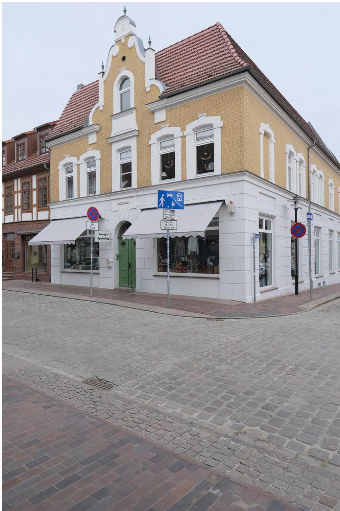
Abbildung 14: Steinstraße 9 nach erfolgter Sanierung
