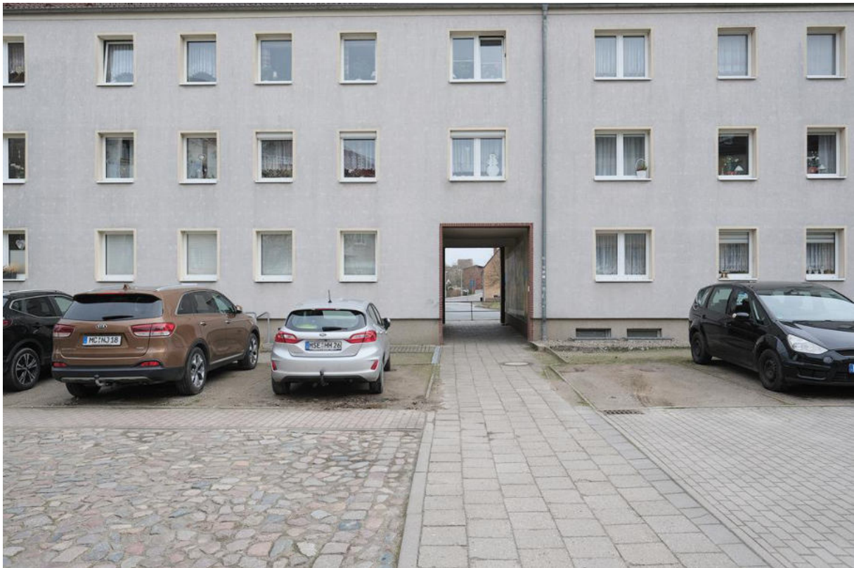
Abbildung 19: rückwärtig angeordnete unbebaute Stellflächen der Blockbebauung an der Teichstraße
