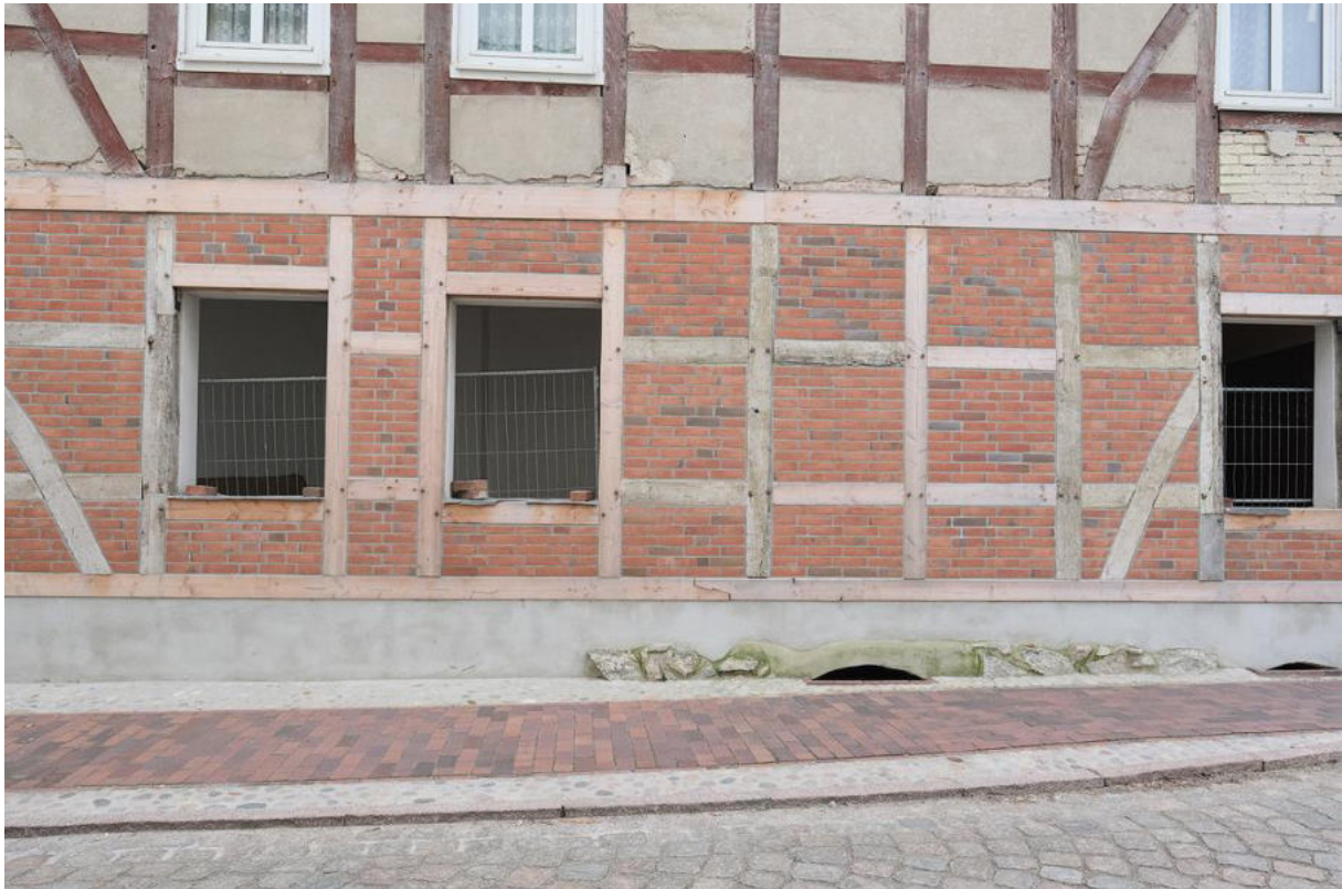
Abbildung 8: Steinstraße 25 nach erfolgter Giebelsicherung
