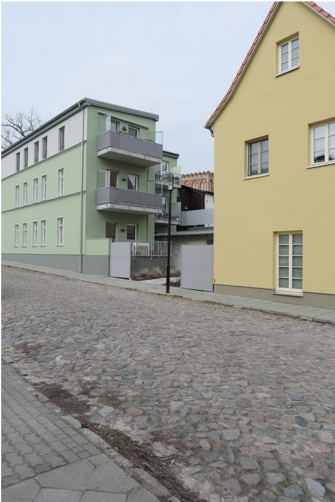
Abbildung 11: Sanierung/Neubau Lindenstraße 5 nach Fertigstellung
