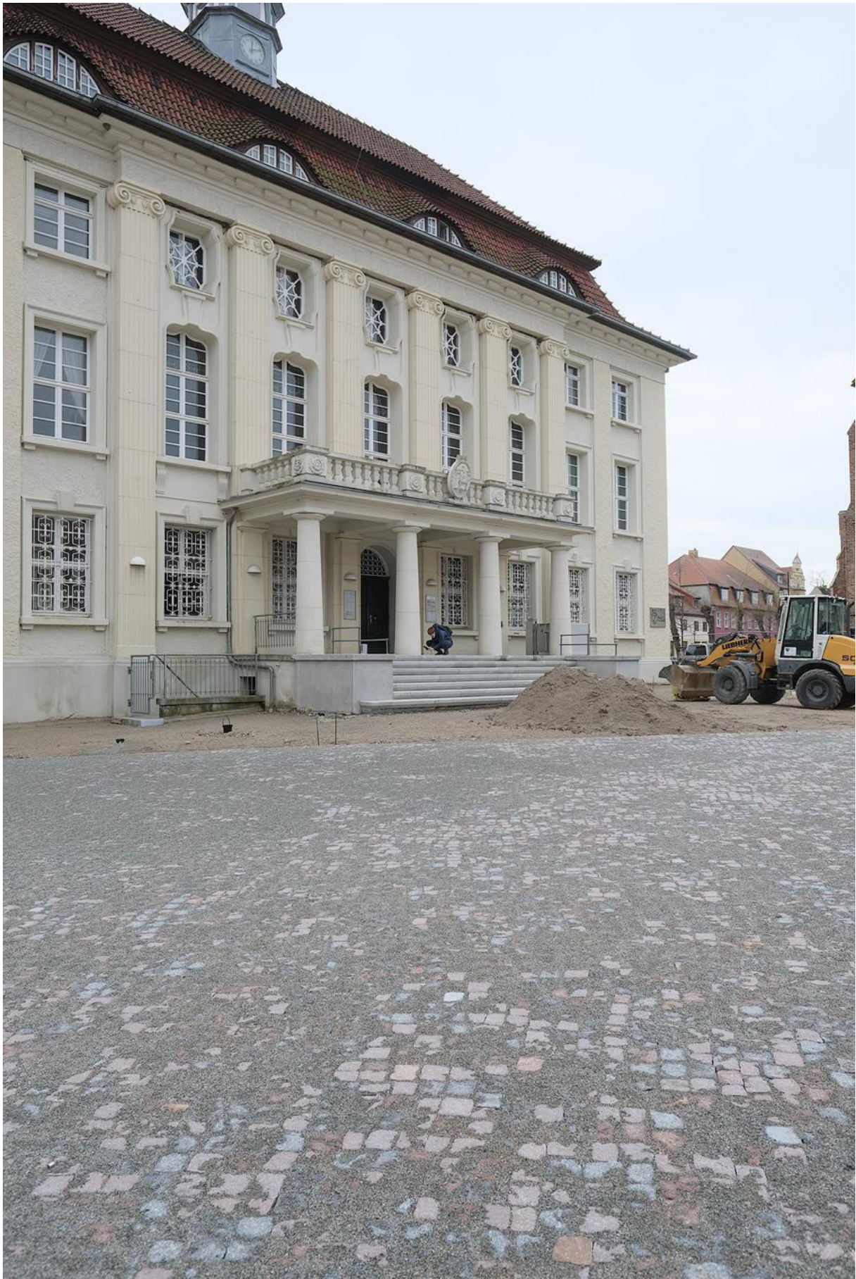
Abbildung 17: Rathaus Malchin vor der energetischen Fenstersanierung
