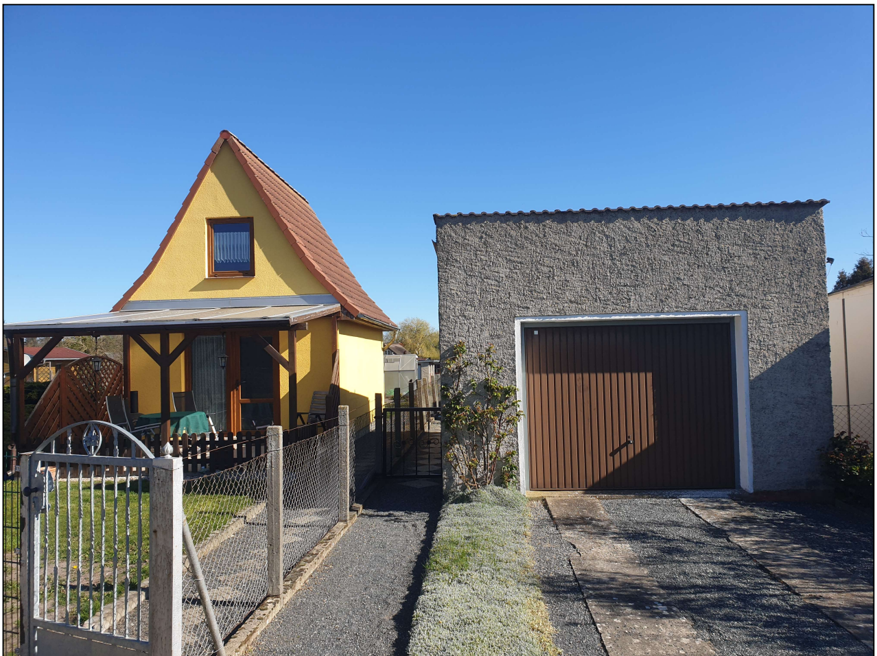
Abbildung 1: baulicher Bestand innerhalb des Geltungsbereiches, Baukonzept Neubrandenburg GmbH, April 2020
