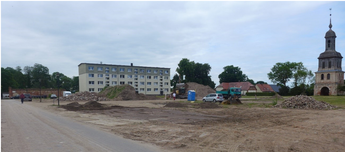
Vom Schlossflügel (Blick auf den südl. Wohnblock während der letzten Arbeiten im Schlossvorhof), Juni 2020
