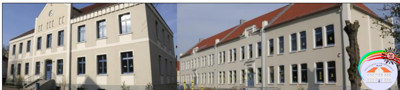
Abbildung 3: Grundschule „Pestalozzi“ Malchin Haus I und Haus II
