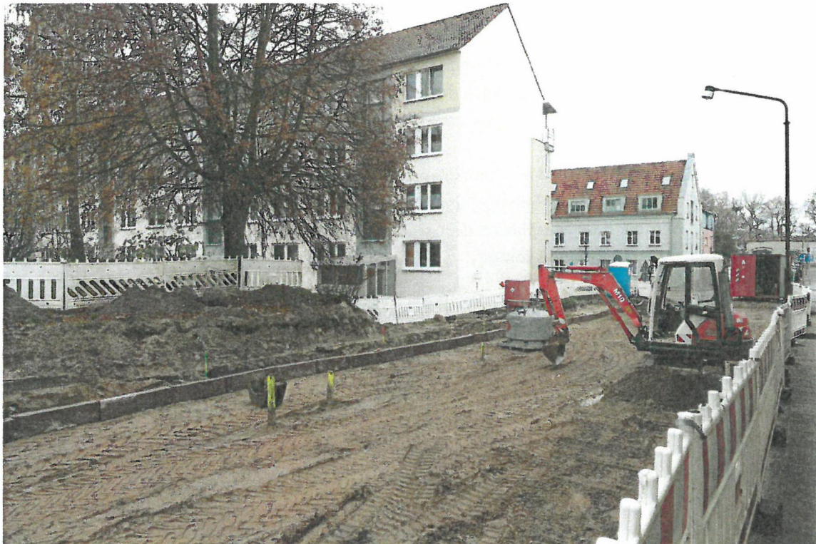
Abbildung 4: Sanierung und Neugestaltung der Petersilienstr./Steintormauerstr.
