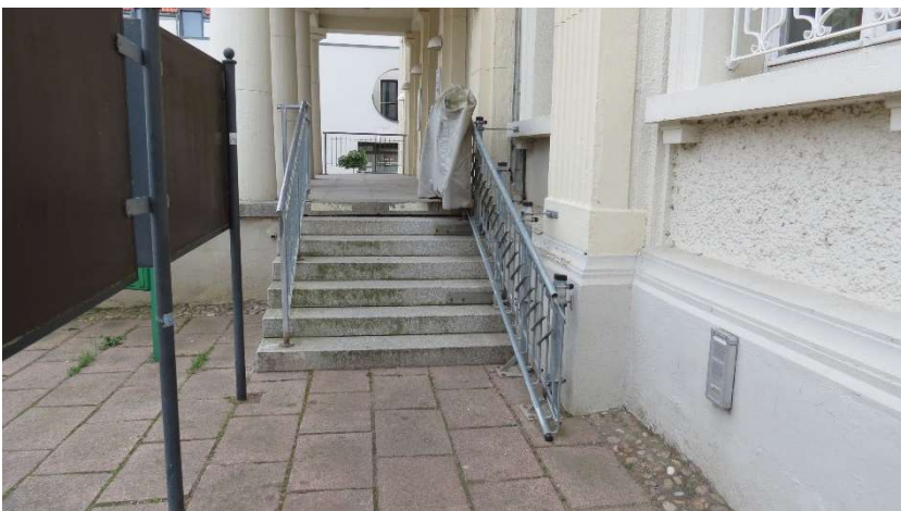
Seitentreppe mit Treppenlift westlich der Treppenanlage
