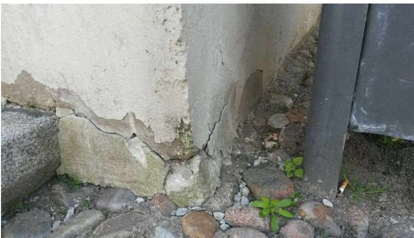
Eckpunkt Treppenwange, westliche Seite der Treppenwange
