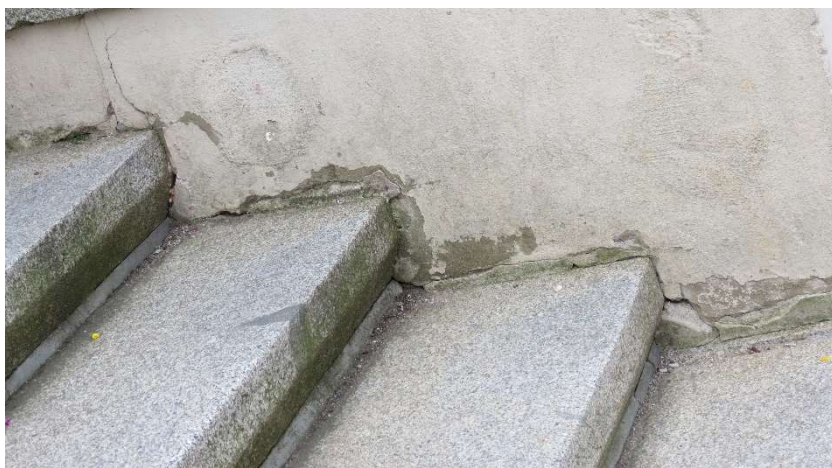
Einbindung der Stufen in die Seitenwange
