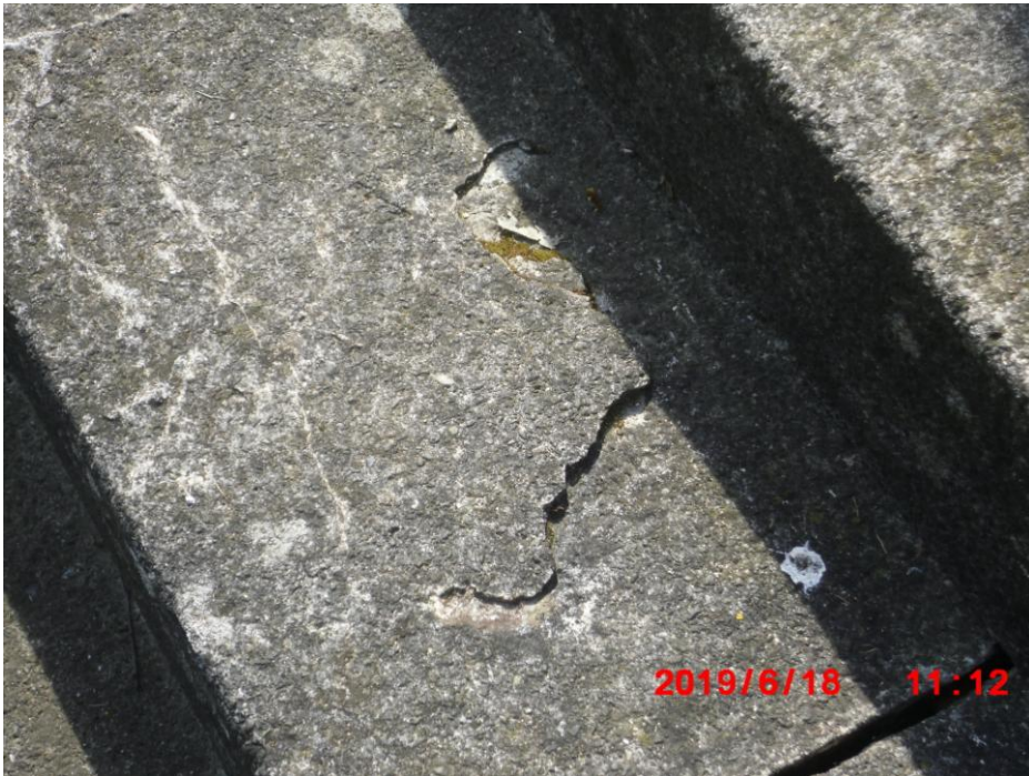
Stufen werden erneuert bzw. aufgearbeitet
