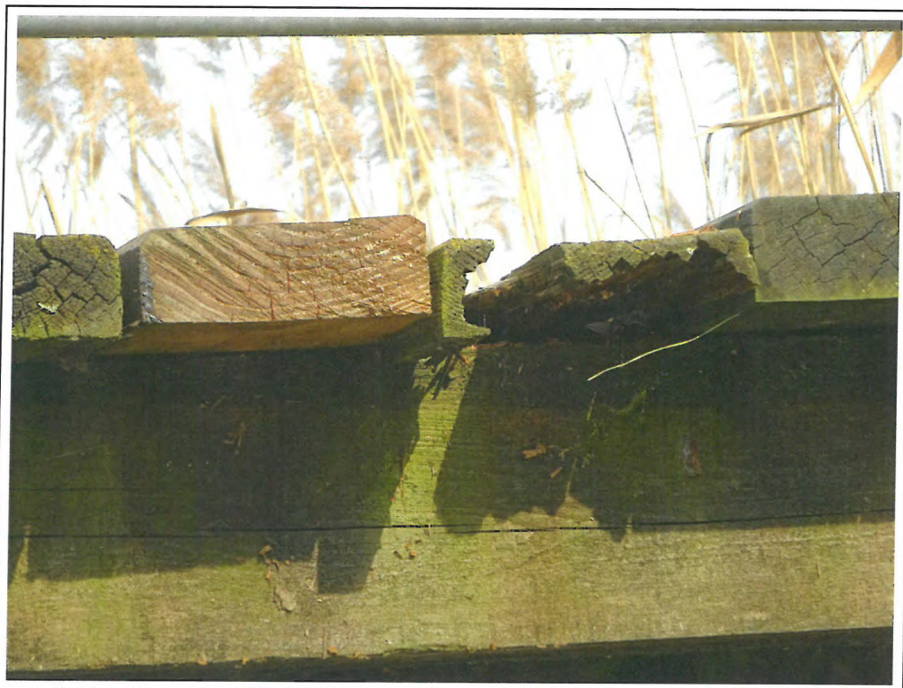
Stirnseite einer verschlissenen Bohle
