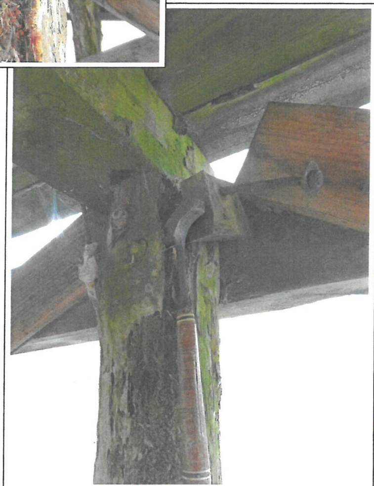
⇒ Pfahl Plattform hinten Mitte
