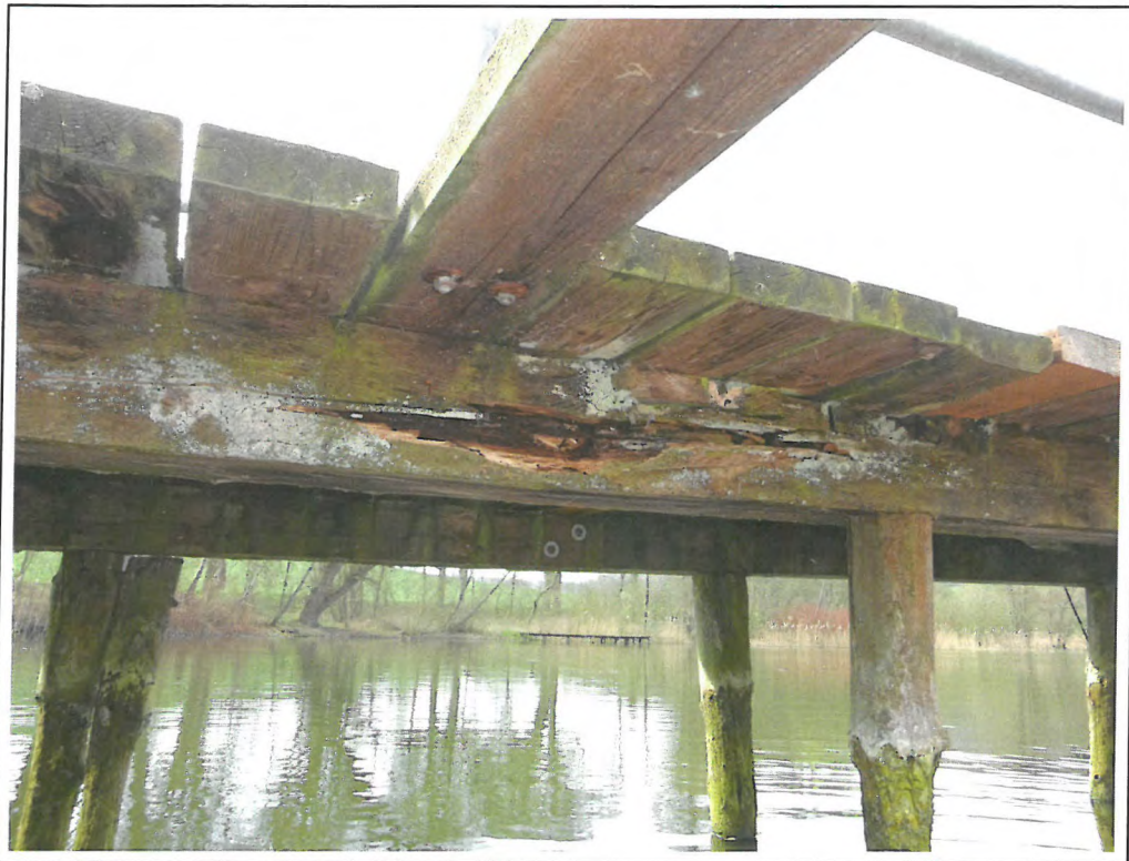
Hauptträger rechts Außenseite
