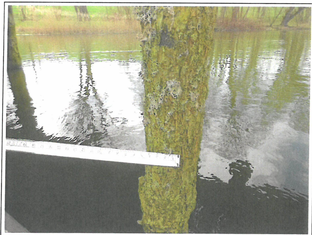
Pfahl mit dem geringsten Durchmesser
