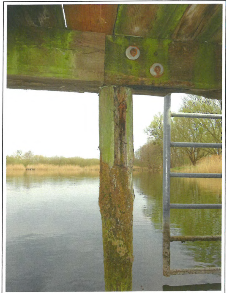
⇒ Pfahl Plattform Mitte rechts
