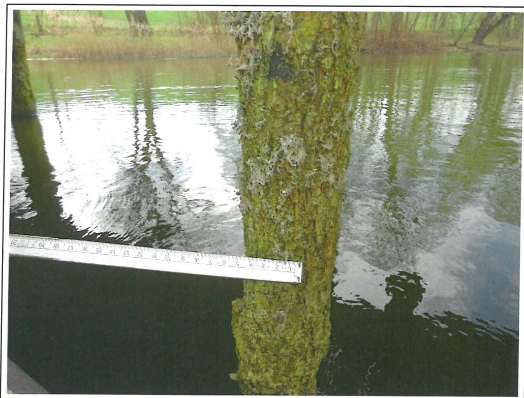
Pfahl mit dem geringsten Durchmesser
