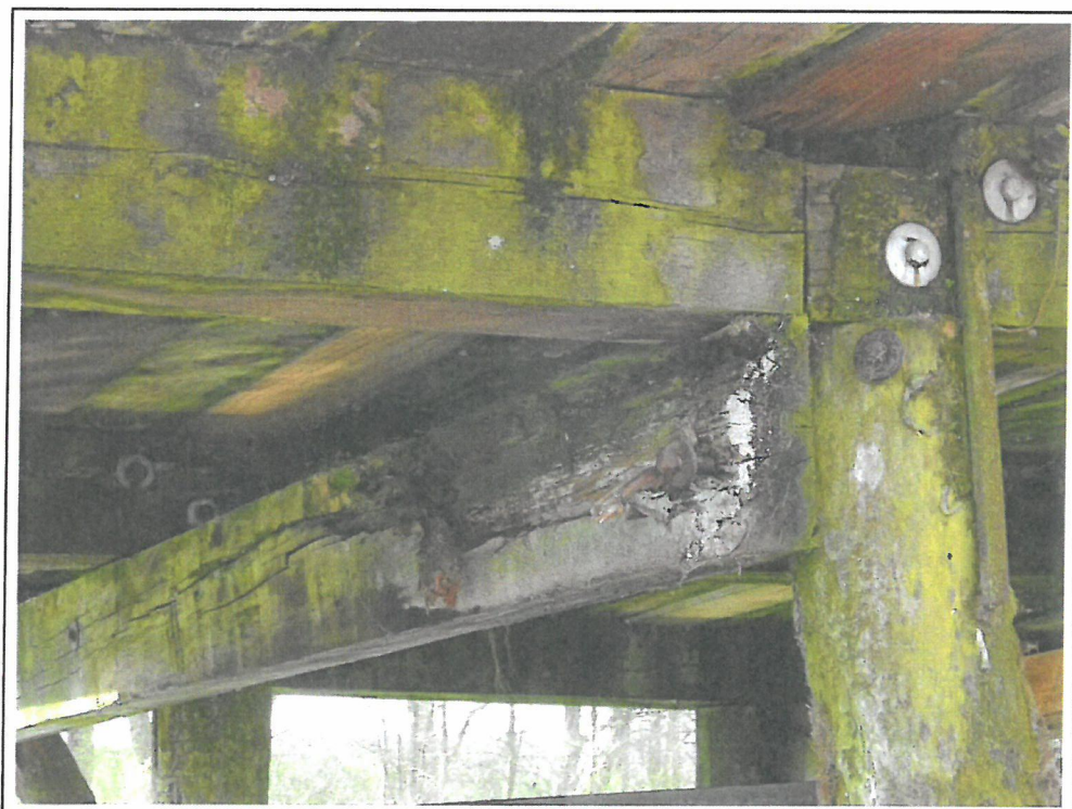
wie vor, Detail Querschnittsschwächung
