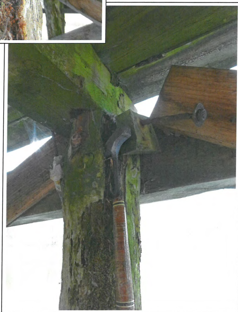
⇒ Pfahl Plattform hinten Mitte
