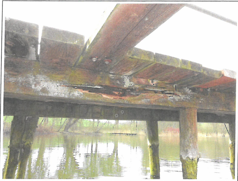
Hauptträger rechts Außenseite
