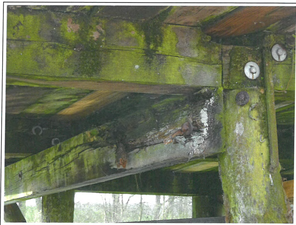
wie vor, Detail Querschnittsschwächung
