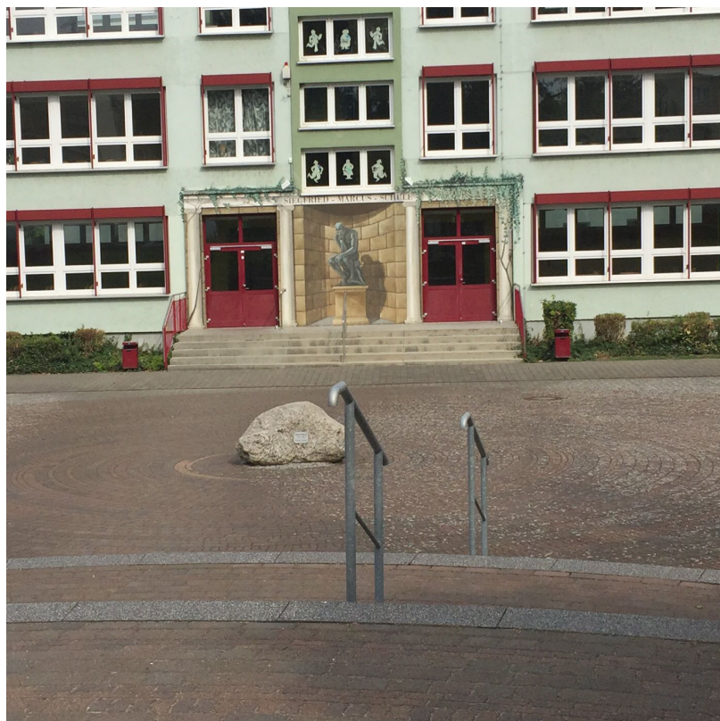
Bestand: Eingangssituation von außen
