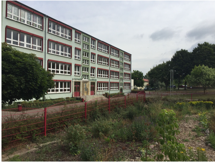
Bestand: Ansicht Straßenseite
