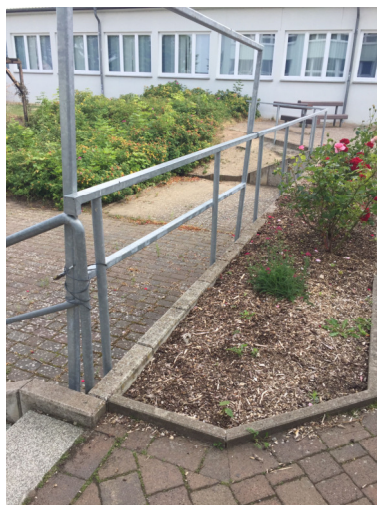
Nebengebäude: Fensterfront Herstellung eines neuen Zugangs
