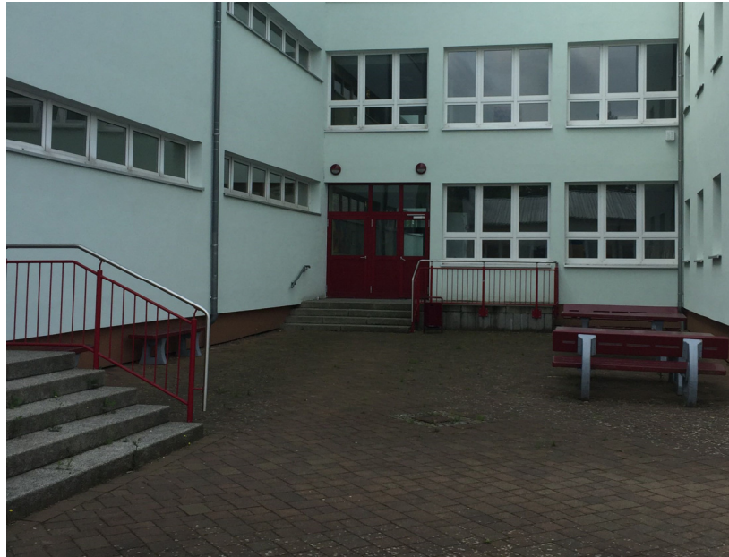
Bestand: Eingangssituation Hofbereich für barrierefreien Zugang durch Anbau Fahrstuhl
