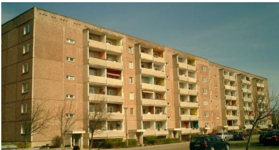
Am Zachow 1-8 – Rückbau geplant
