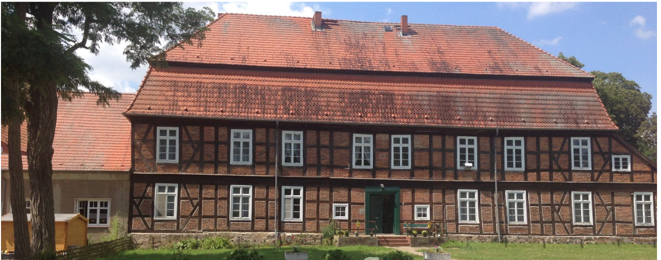
Schlosstraße 11: mittlerer Bauzustand, Denkmal, Wohnnutzung
