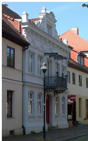
Schweriner Str. 17 (Sanierung 2012/13)
