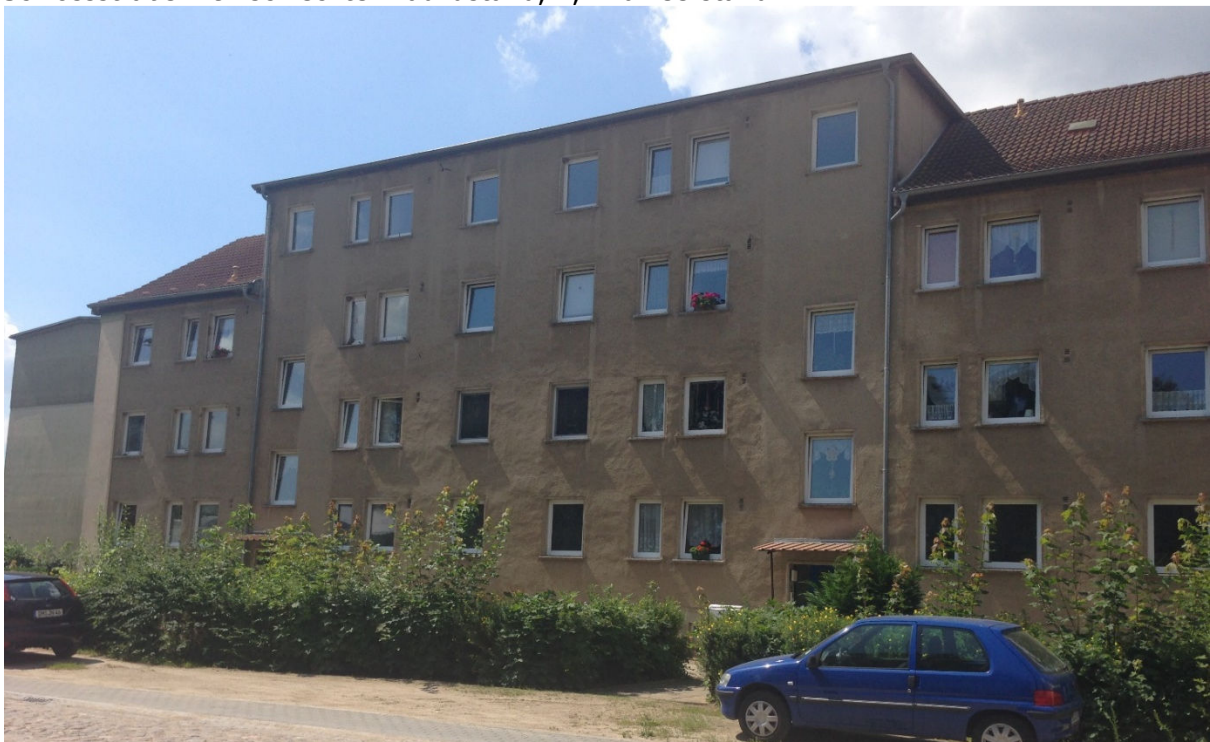
Schlossstraße 4/5: schlechter Bauzustand, 57,1 % Leerstand (Totalrückbau 2017)
