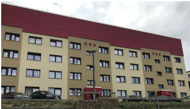
H.-Heine-Straße 17-19 – Sanierung 2014, oberste Etage stillgelegt
