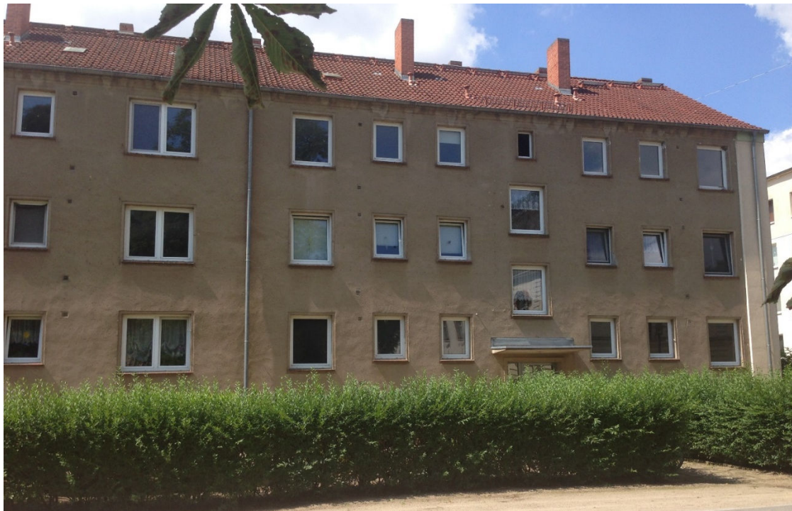
Schlossstraße 2/3: schlechter Bauzustand, 46,6 % Leerstand (Totalrückbau 2017)
