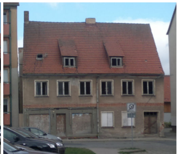
Achterstraße 9 – unsaniert, Abriss 2017
