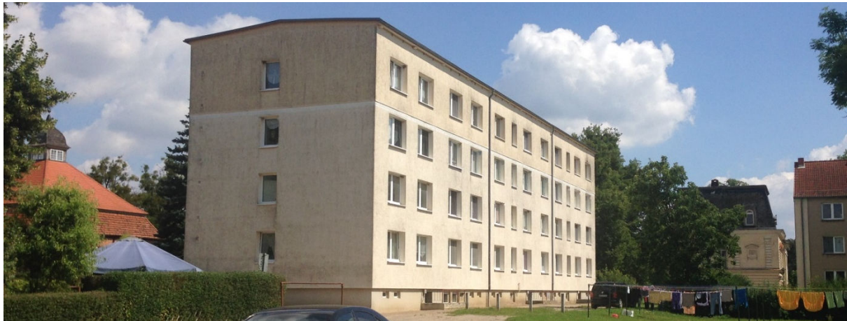
Schlossstraße 12-14: schlechter Bauzustand, kein Leerstand
