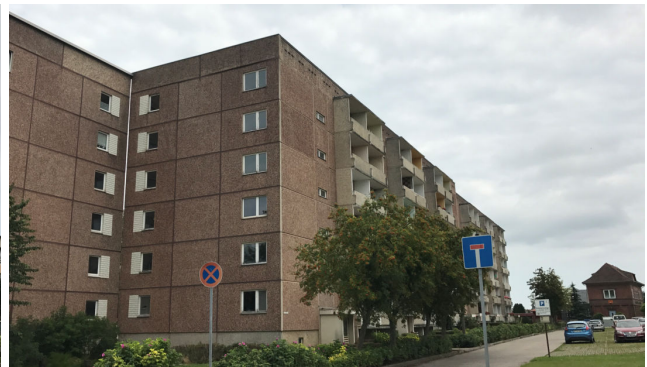
Am Zachow 1-4 und 5-8 – unsaniert, Rückbau geplant
