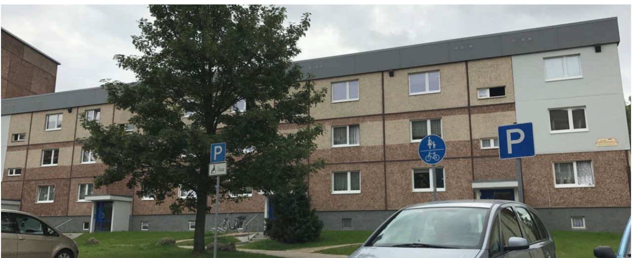
etagenweiser Rückbau Am Zachow 23-26
