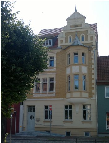
Schweriner Str. 11 (Sanierung 2011)
