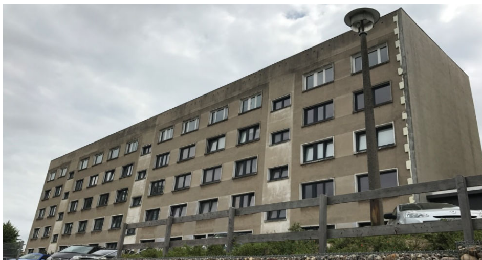
H.-Heine-Straße 14-16 – Sanierungsbedarf, oberste Etage bereits stillgelegt
