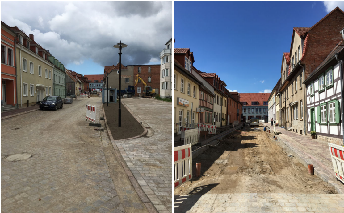
Lange Straße/Pastinakerstraße – während der Neugestaltung
