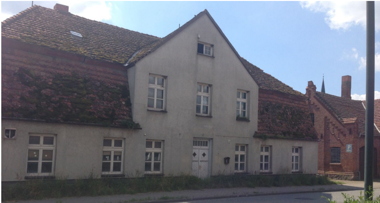
Dorfstraße 54: im Bestand gefährdet, Denkmal, komplett leerstehend
